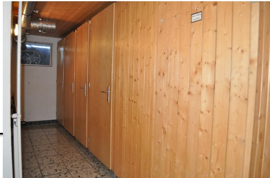
WC-Anlagen und Einzelwaschkabine/Dusche
